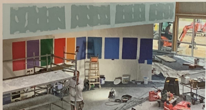
Der Innenausbau der neuen Halle ist schon in vollem Gange.
